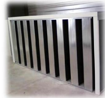
Lors d'installation d'entrées d'air statiques ou dynamiques, à partir d'une étude, nous serons susceptibles de réaliser vos silencieux à baffles parallèles afin de réduire les nuisances sonores pour l'environnement extérieur et de répondre aux exigences en matière de niveau acoustique en limite de propriété tout en maintenant la perte charge du circuit aéroulrique à une valeur acceptable.
