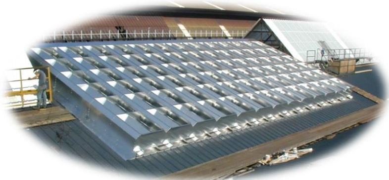
Aérateurs « tout temps » étudiés afin d'éviter des surcharges sur vos toitures existantes ( $50 \text{ kg/m}^2$ ), permettent une ventilation de locaux industriels existants non calculé pour recevoir des équipements supplémentaires.
