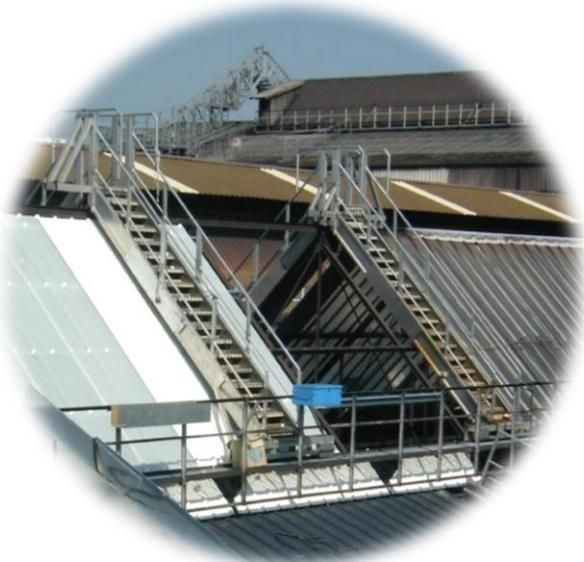
Passerelle de démontage aluminium
